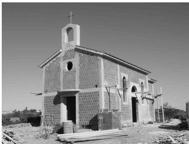
Izgradnja kapelice na groblju
